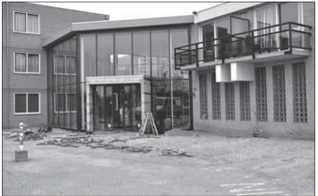
* Eén van de diverse bouwactiviteiten
