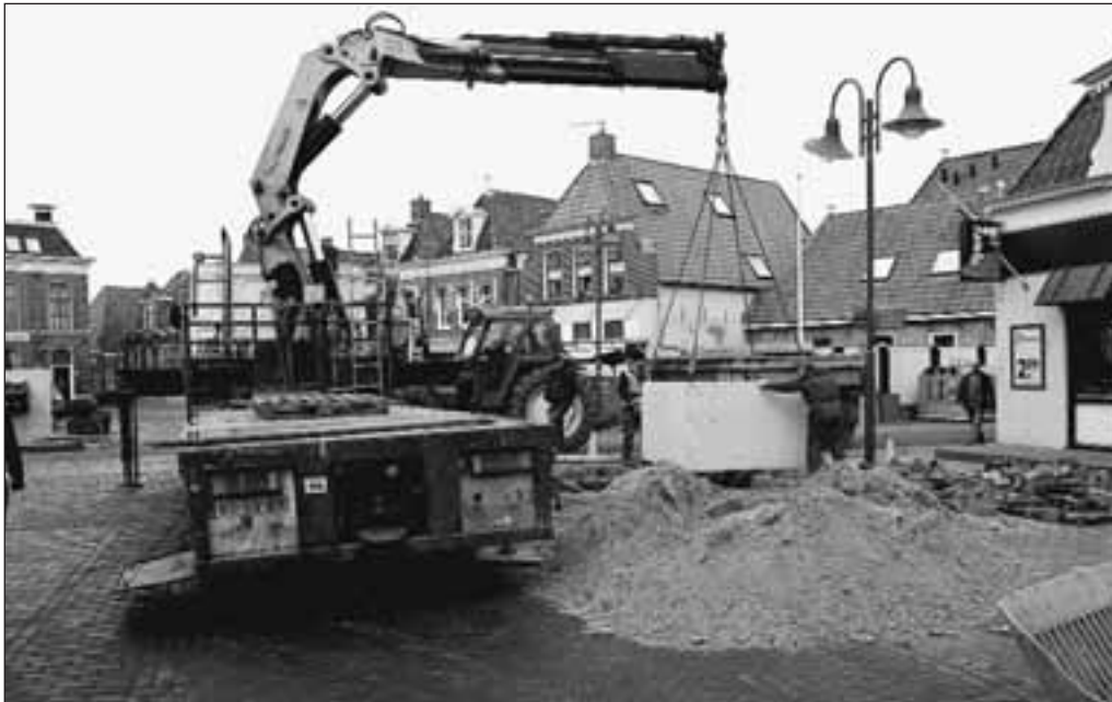
Vrijdagmorgen is er een glasbak geplaatst tegenover supermarkt van der Wal. Voordat de glasbak geplaatst kon worden werd er eerst een flink gat gegraven waarin de bak geplaatst kon worden. De oude glasbol wordt t.z.t. verwijderd.
