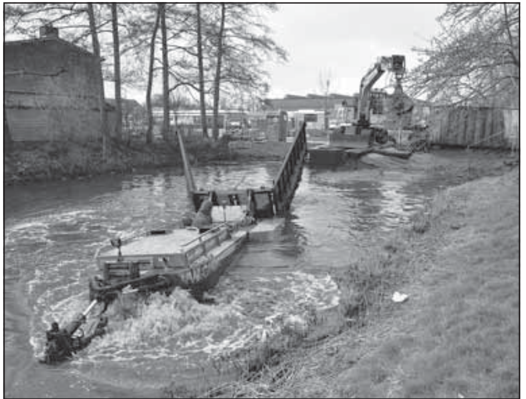
* De baggerwerkzaamheden van de Melkvaart in volle gang.
