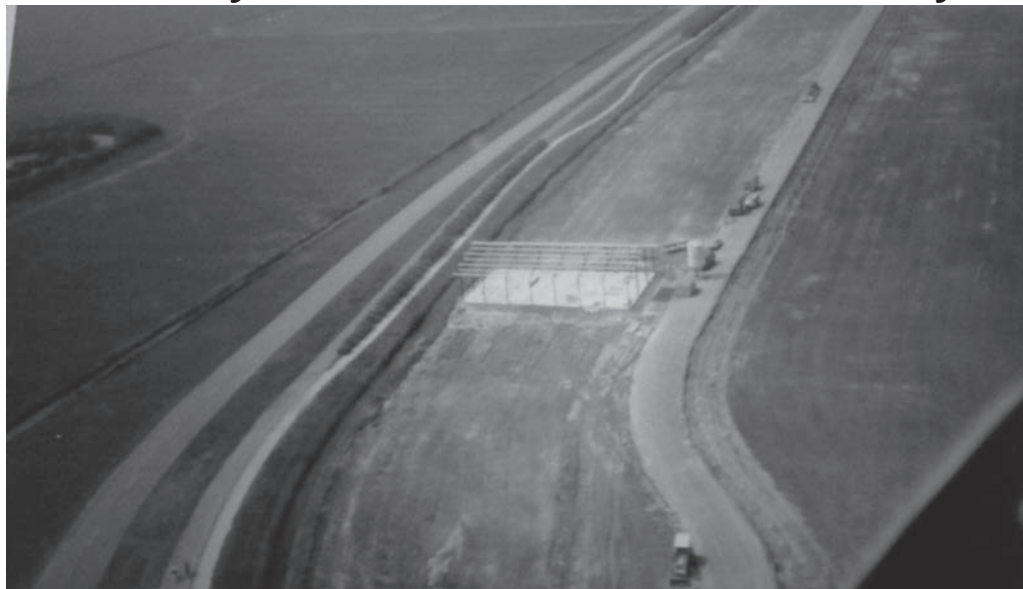
Het eerste pand in aanbouw op industrieterrein 'Zuidwaard'
